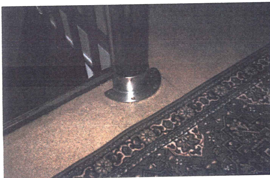
Gulv i foyer - detalj rustfritt stålbeslag på rekkverksmegler foto BDF - AF
