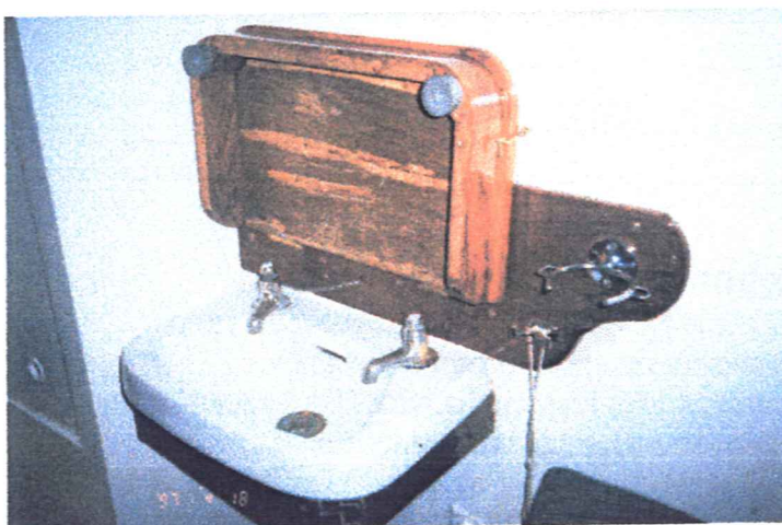
Original Shanks servant 40 x 28 cm, med trykk-armatur. Dør i klesskap til venstre med luftehull. Foto BDF / AF.
