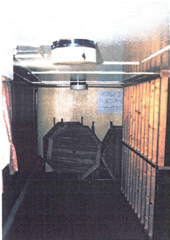
Omr. 307, liten gang / repos ved 2. kl. røykesalong
