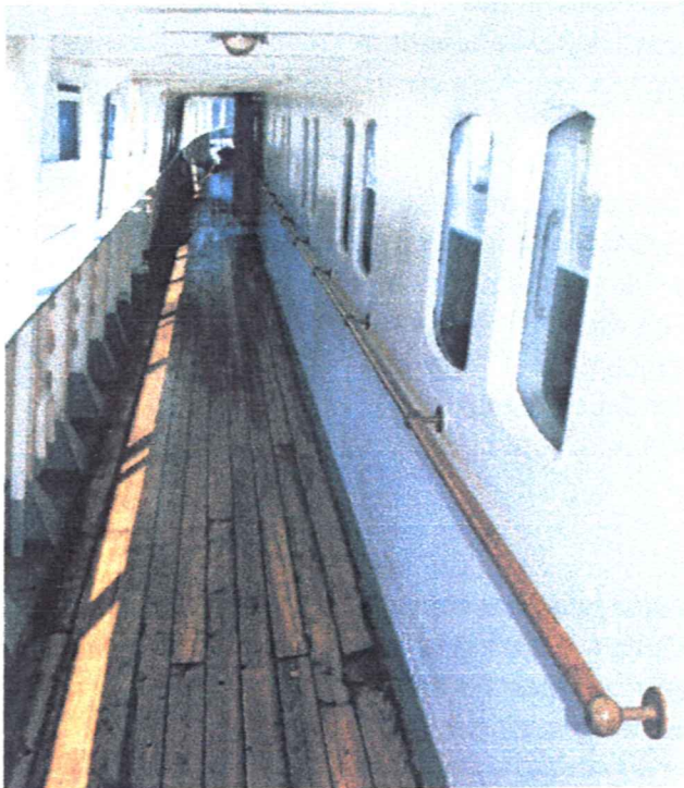
Stormdekk dekksp plank foto BDF – AF
