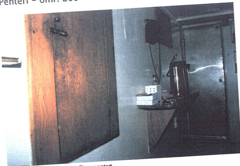
Nye originale keramiske gulvfliser montert.
