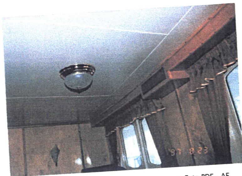
Gammelt og nytt - airconditioningsystemet renovert. Foto BDF - AF.
