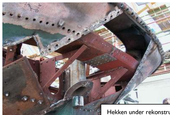
Hekken under rekonstruksjon
